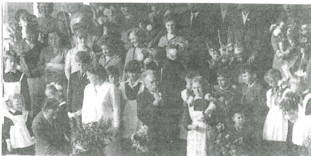
Митинг, посвященный открытию нового здания школы, сентябрь 1967 г.
